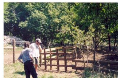
Ocenjevanje popravila ograde
